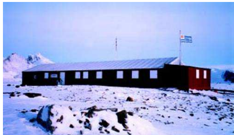
Aspecto de la ECARE en el verano 1997-1998, una vez culminadas las refacciones y remodelación
